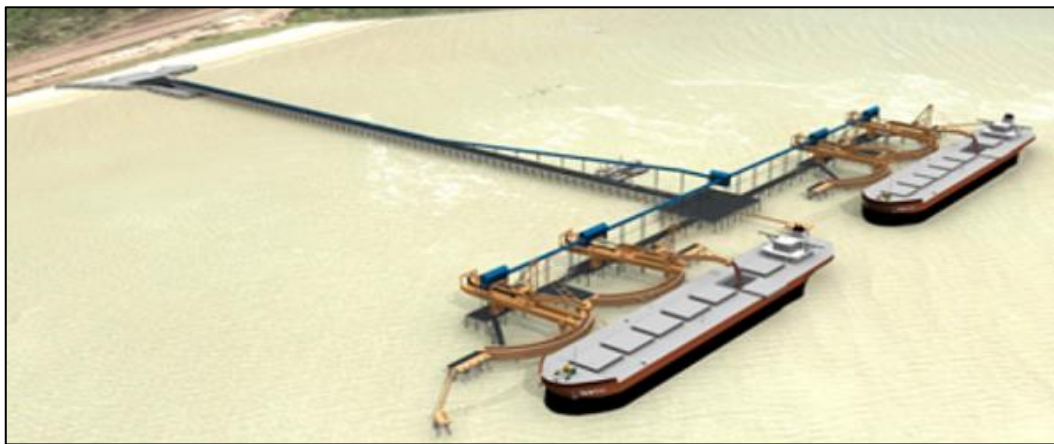
Figura 6: Extensão do Píer 4 - Berços Norte e Sul. Fonte: Vale, 2024.
