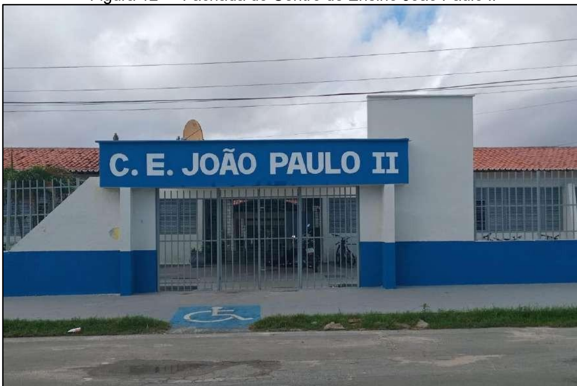
Figura 12 - Fachada do Centro de Ensino João Paulo II
