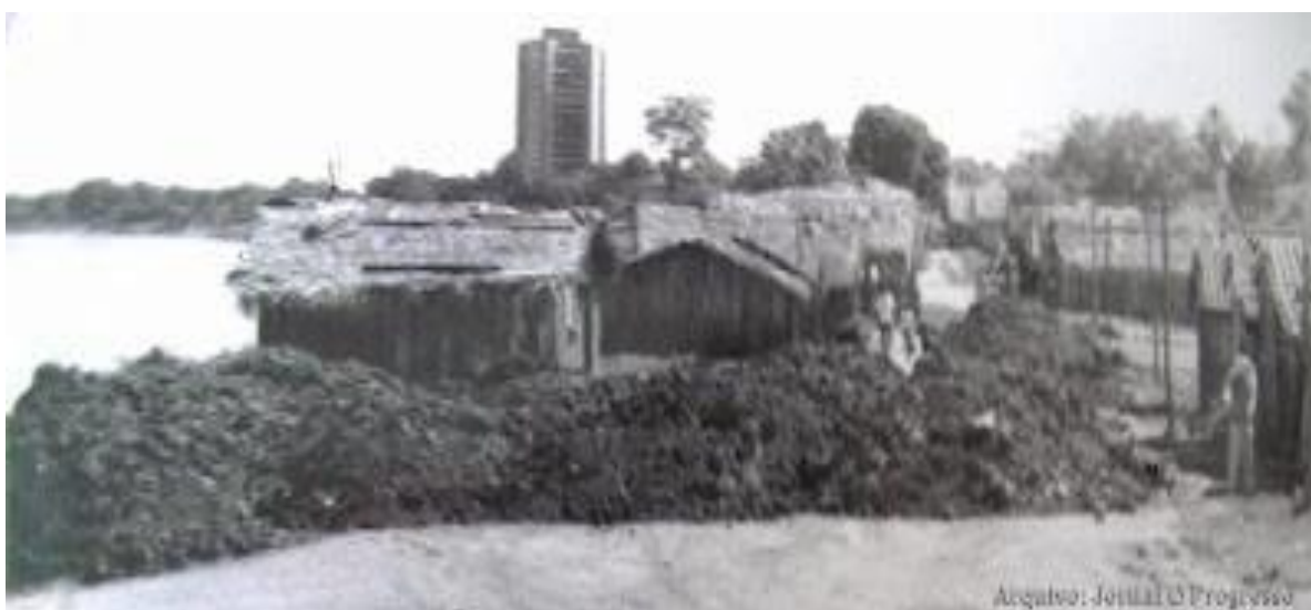
Construção da Avenida Beira Rio, em 1954, umas das principais ruas de Imperatriz-MA no centro urbano da cidade, antes da construção da rodovia. Todas as relações comerciais com o Norte Goiano e Sudeste do Pará saíram deste ponto. Fonte: Jornal O Progresso
