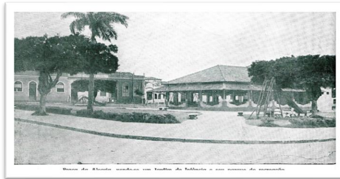
Imagem 5 – Prédio do Jardim de Infância Decroly
