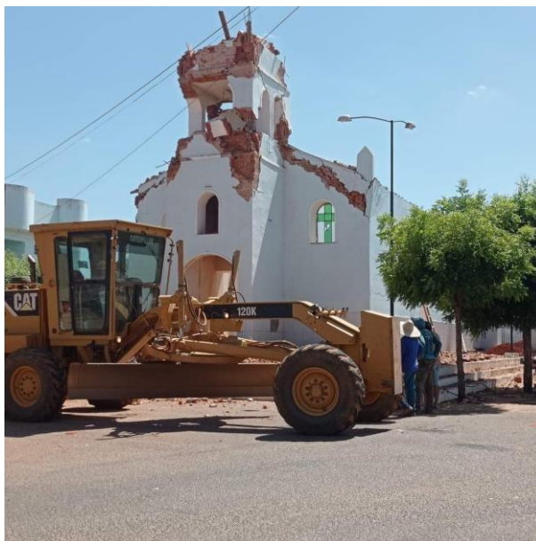
Figura 11: Demolição da igreja de Bocaina (2023).
