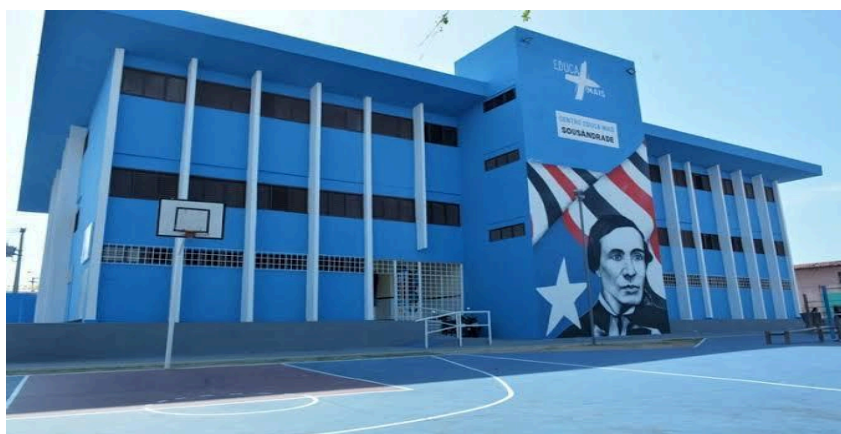
Figura 18: Fachada após a reforma do Sousândrade
