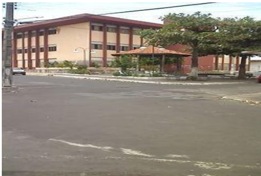
Figura 17: Fachada Antiga do Sousândrade
