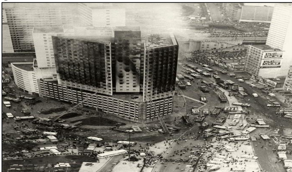
Figura 1 - Edifício Joelma em chamas – SP
