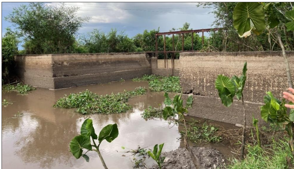
Figura 22: Barragem no igarapé do Nema em Arari -MA, Brasil
