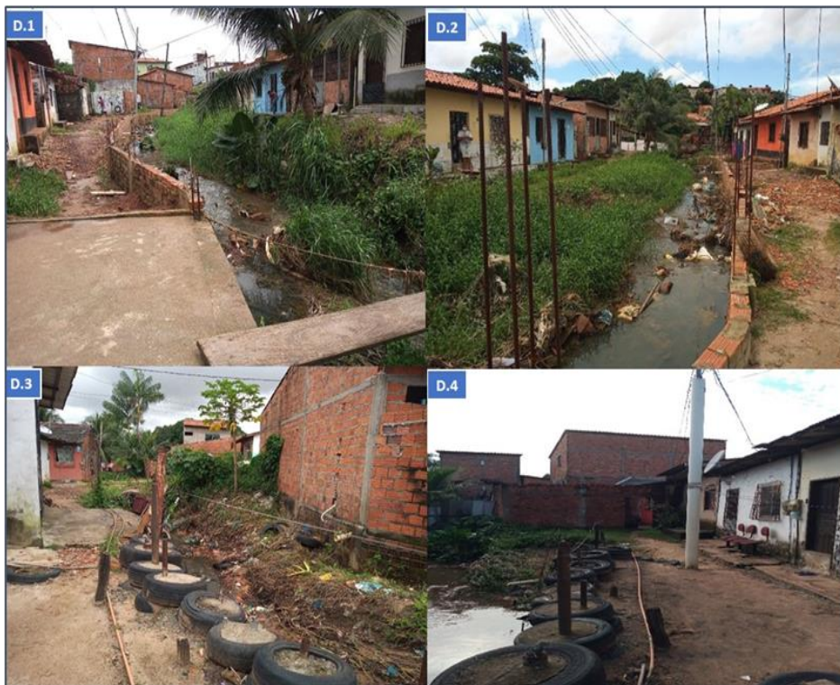
Figura 36 - Obras de contenção feitas pelos moradores
