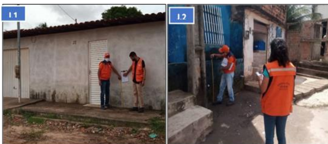
Figura 45 - Medição da altura de água máxima alcançada na área/edificações
