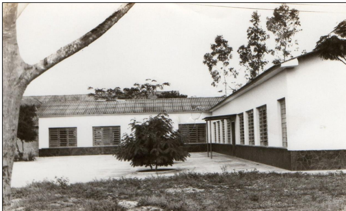
Figura 21: Prédio do Jardim de Infância
