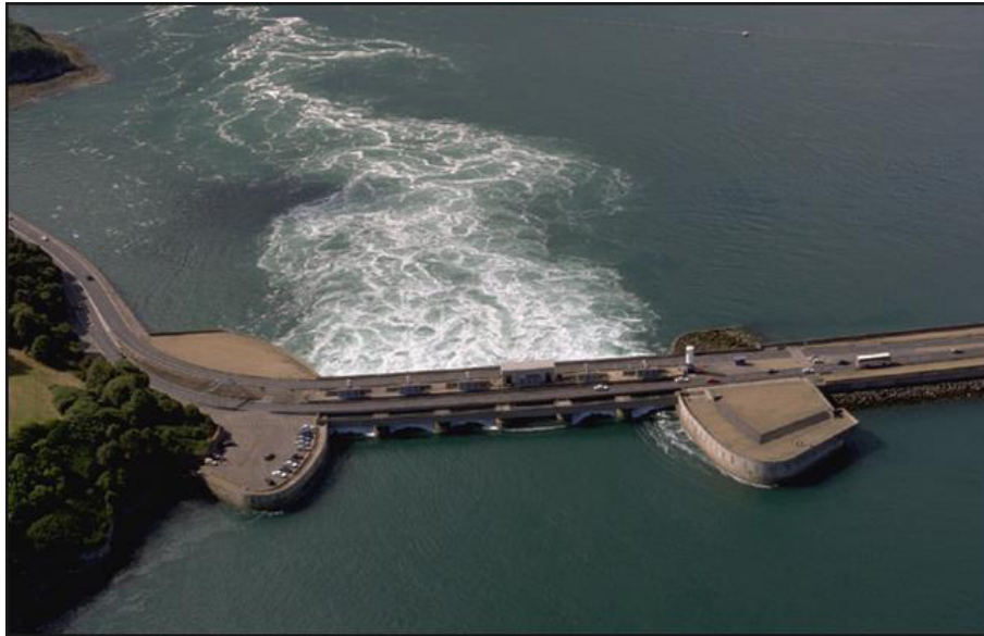
Figura 11 – Usina de La Rance, França. 24 turbinas de 10 MW cada com 5,3 m [12].
