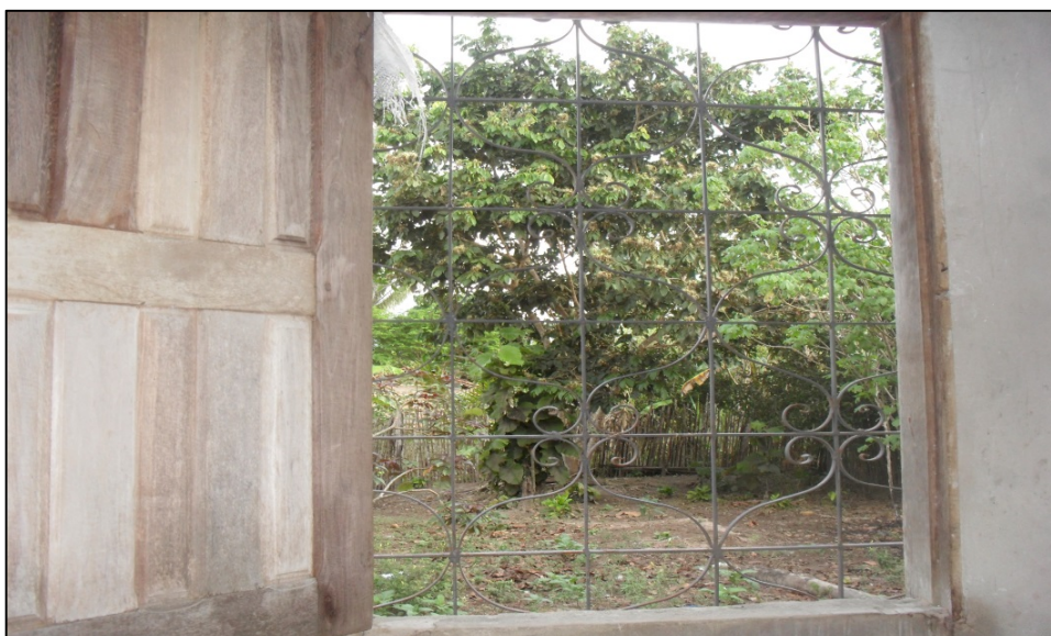
FIGURA 09: Janela de uma casa de alvenaria em Ariquipá com grades de ferro. FONTE: SILVA, 2013.
