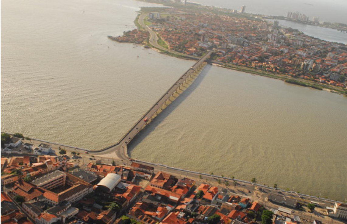
Figura 8: Ponte José Sarney
