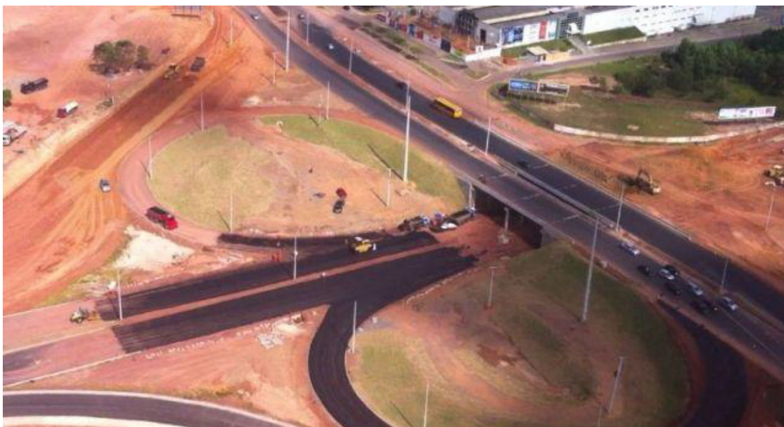
Figura 6: Vista aérea da construção da Avenida Via Expressa Fonte: luiscardoso.com.br
