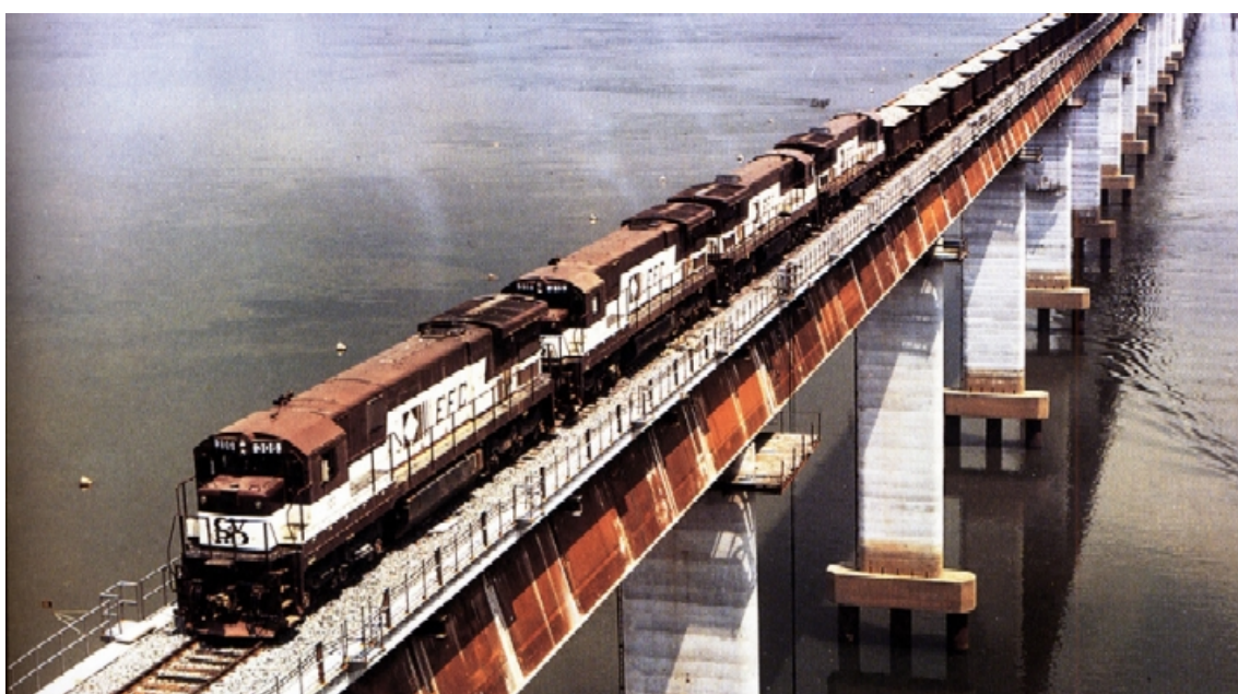
Figura 11 – Trecho da Estrada de Ferro Carajás
