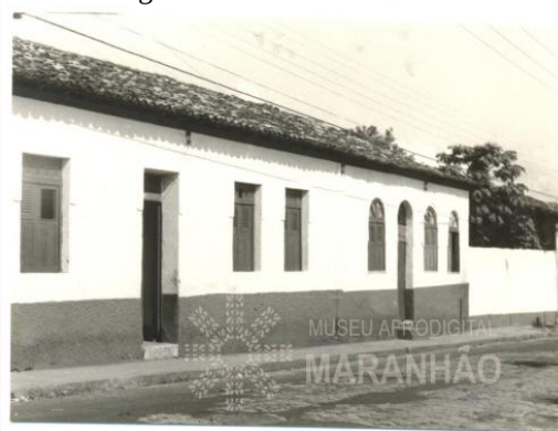
Figura 32 – Fachada Casa das Minas
