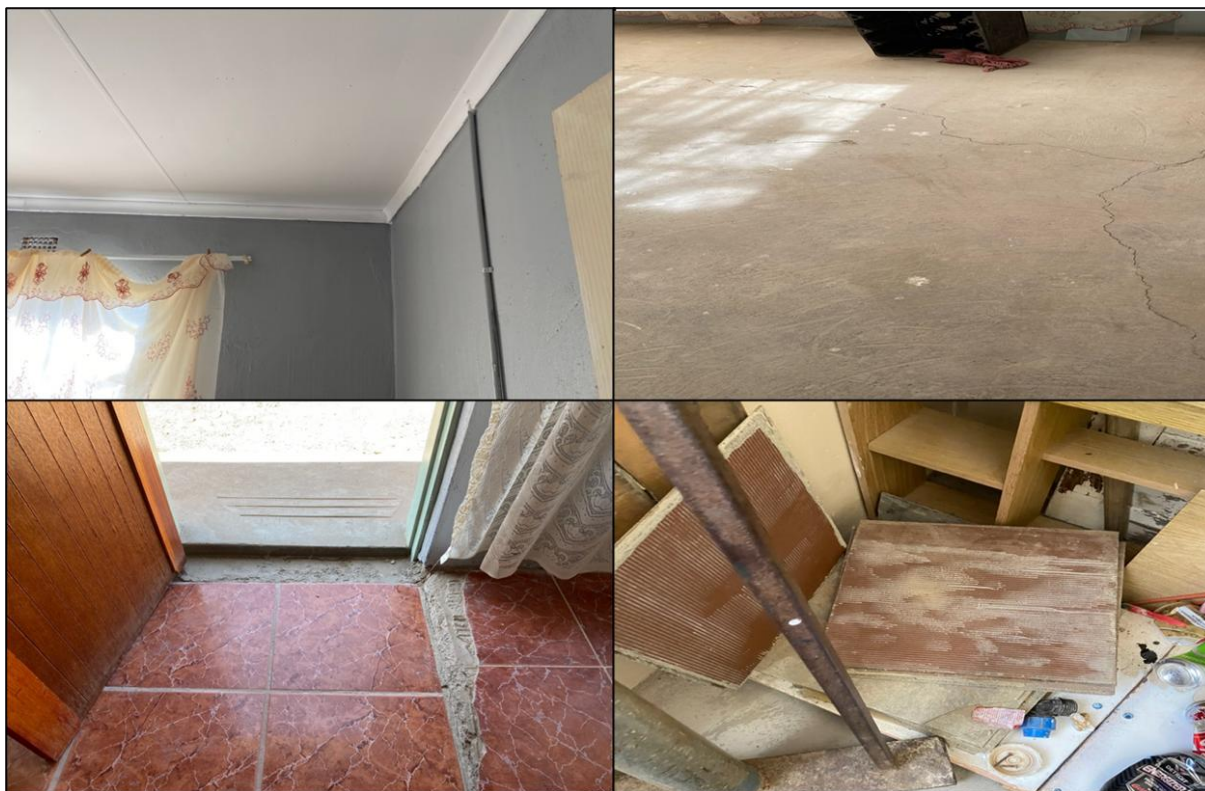
Figura 88 - Necroarquitetura e abandono na reforma das casas em Itumeleng e Charlesville Fotos: Autora (2024). Fotos tiradas no trabalho de campo.
