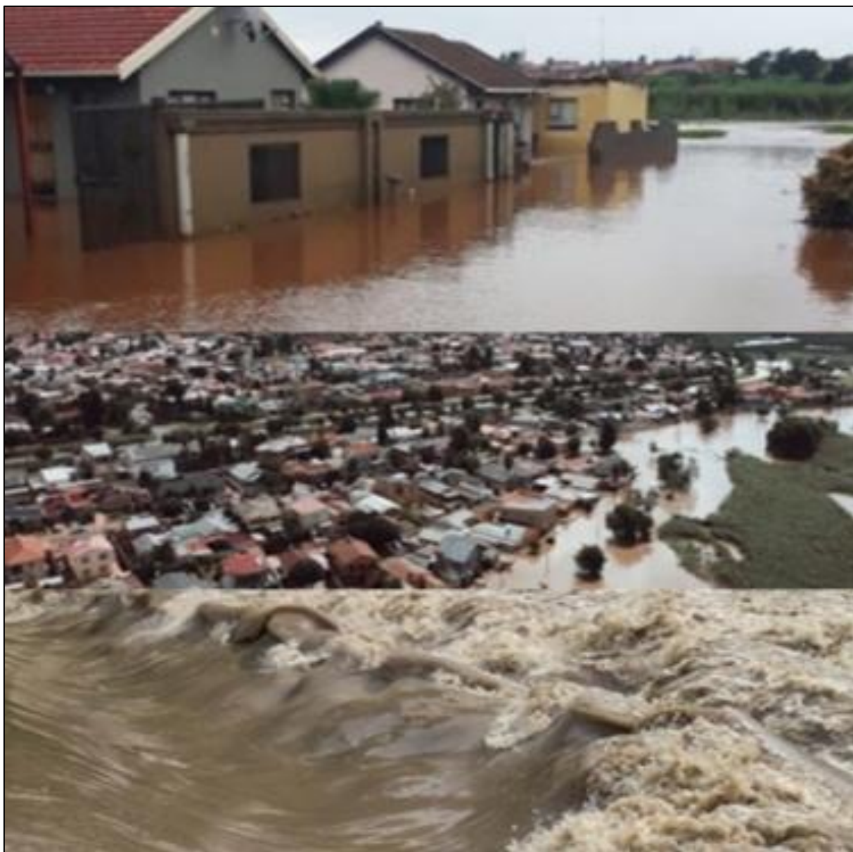
Figura 64 - Inundação pelo rompimento de talude barragem em Snake Park Fonte: Bench Marks Foundation arquivos (2014).
