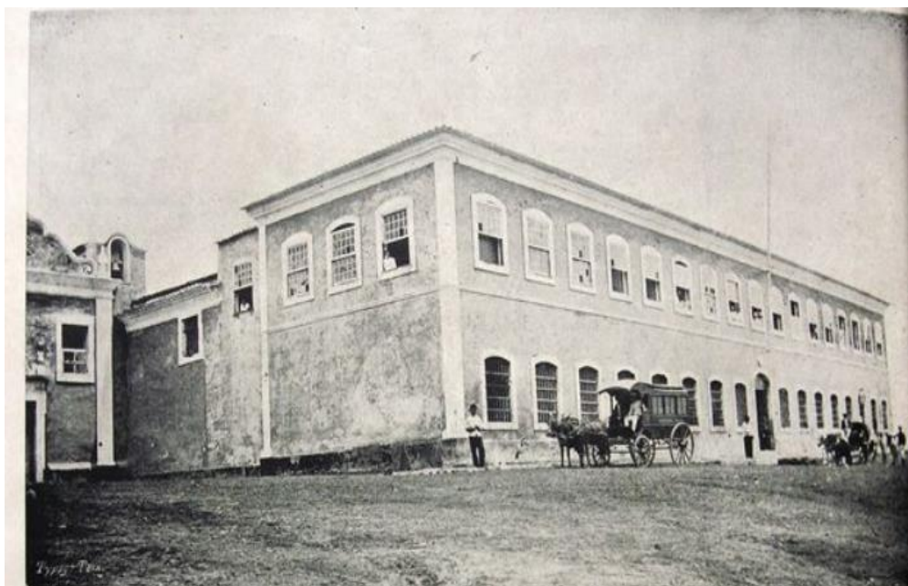
Figura 10 – Fachada do Hospital de Isolamento
