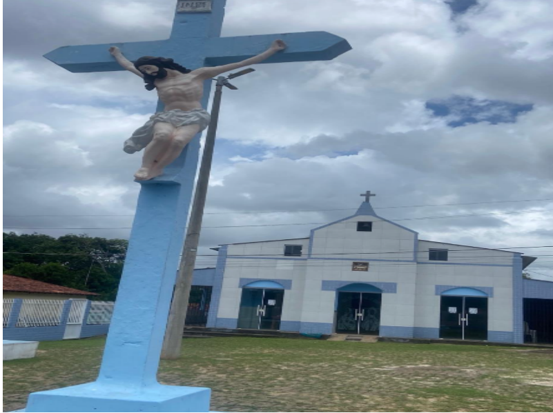
Figura 7- Fachada da igreja Nossa Senhora Mãe dos Homens
