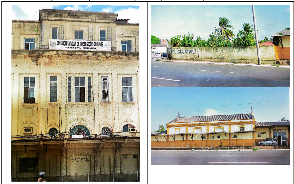
Quadro 6 - Registros das delegacias no prédio da Estação João Pessoa
