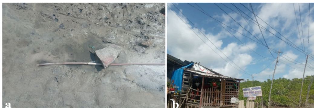
Figura 3: Alternativas irregulares para suprimento de serviços de infraestrutura básica. a) encanamento de água instalado de forma irregular, parcialmente enterrado no solo do manguezal. b) fiação elétrica instalada de forma irregular e desorganizada.
