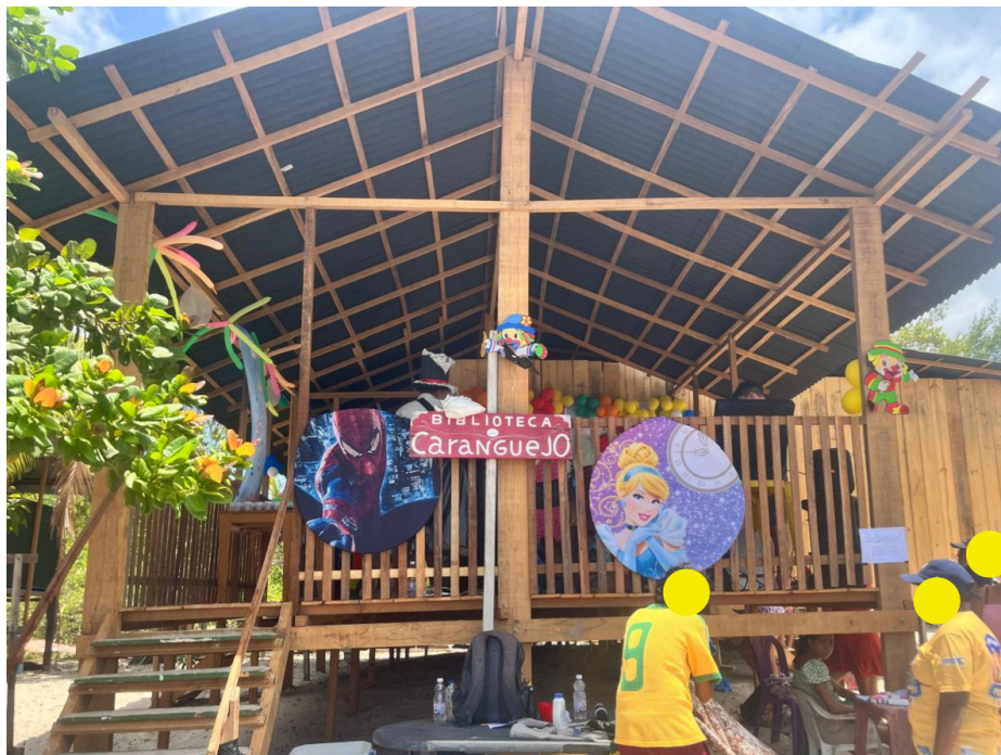
Figura 7: Biblioteca do Caranguejo durante a reforma da estrutura física.
