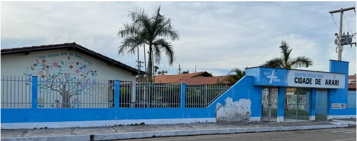
Figura 2: Foto de vista da escola.
