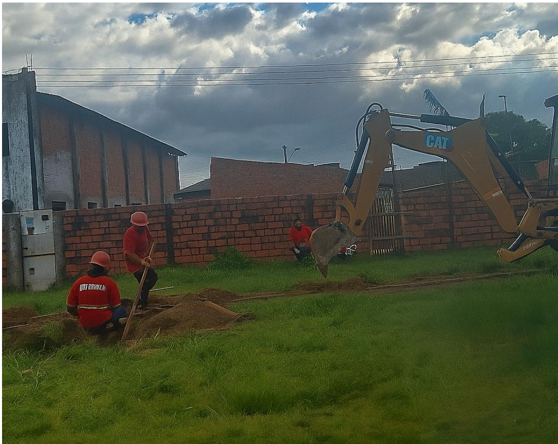
Imagem 09: Trabalhadores fazendo a manutenção dos trilhos
