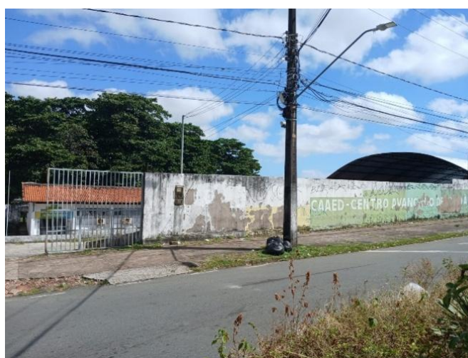
Figura 3- Fachada do prédio do Centro Avançado de Apoio ao Educador (CAAED)
