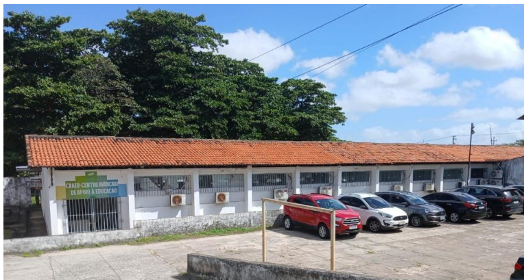
Figura 4 - Fachada do prédio do Centro Avançado de Apoio ao Educador (CAAED)
