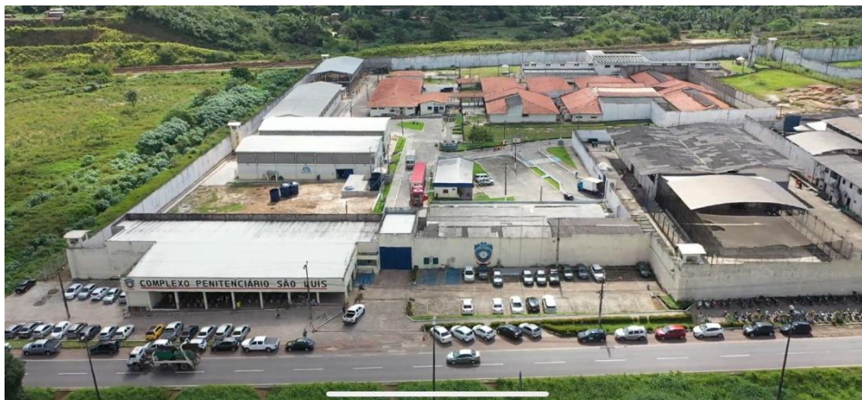
Figura 5 - Foto de drone da entrada do Complexo com a portaria unificada que dá acesso às unidades. No canto esquerdo está a portaria, após, na entrada, estão dois galpões de oficinas. Ao fundo as unidades UPRSL 4 e 5, no canto inferior direito está a UPRSL 3. Subindo a ladeira para a direita ficam as unidades 1, 2 e 7, além da fábrica de bloquetes. Fonte: SEAP-MA.
