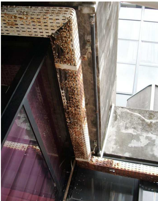
Eletrocalha oxidada
