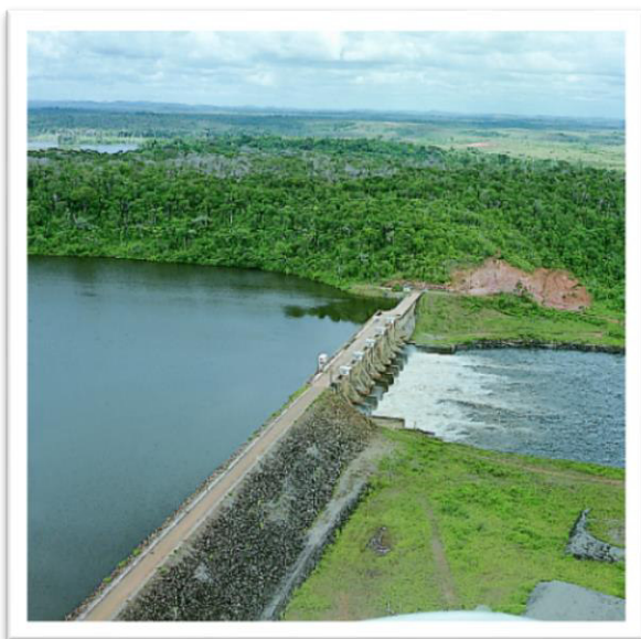
Figura 9 – Usina de Coaracy Nunes ou Paredão.
