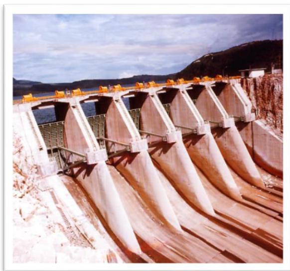
Figura 4 – Obras de construção do vertedouro da Usina Hidrelétrica de Furnas.
