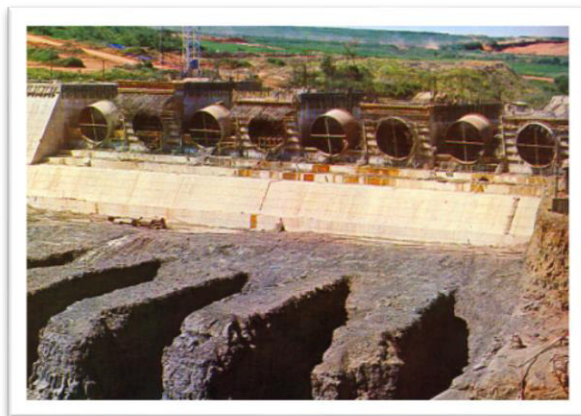
Figura 8 – Construção da Usina de Marimbondo.
