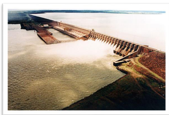
Figura 7 – Usina Hidrelétrica de Ilha Solteira.
