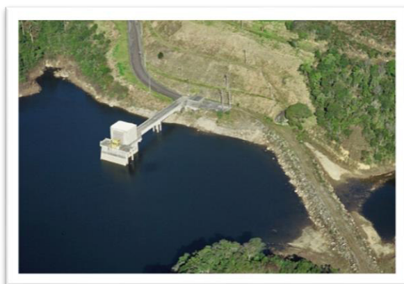
Figura 6 – Usina hidrelétrica Capivari-Cachoeira.
