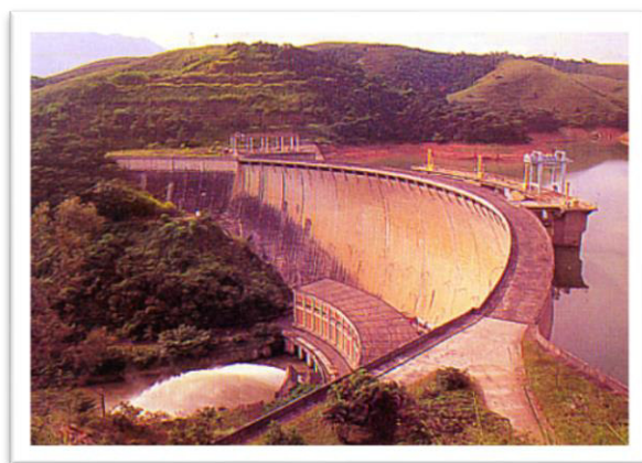
Figura 5 – Vista da barragem da Usina Hidrelétrica Funil.
