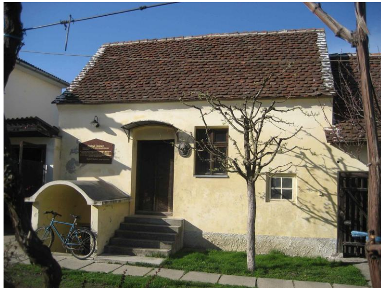
Figura 4 – Casa onde nasceu Rudolf Steiner
