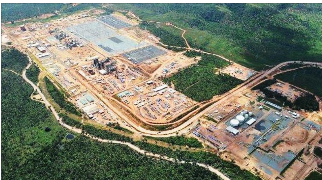
FIGURA 04 - Complexo termoelétrico – UTE Parnaíba (Santo Antônio dos Lopes - MA) Fonte: GASMAR, 2015.
