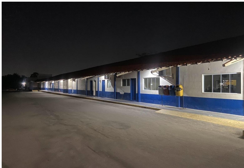
Figura 6 – Passadiço interno da APMGD
