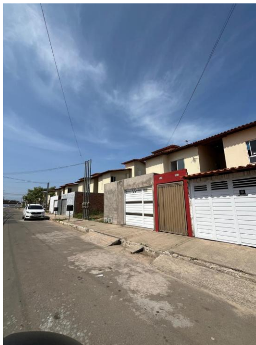
Figura 35 – Extensões construídas aos limites da calçada frontal
