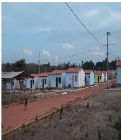
Figura 8 – Residencial Maria Firmina I e II em Paço do Lumiar – MA
