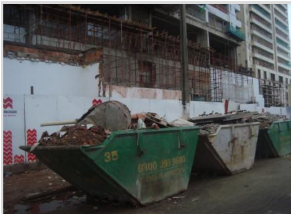
Foto 10 – Material misturado nos contêineres de uma transportadora – no bairro da Ponta da Areia: os resíduos estão todos misturados, ou seja, não há segregação por classe como estabelecido pela legislação. (18/07/2014)
