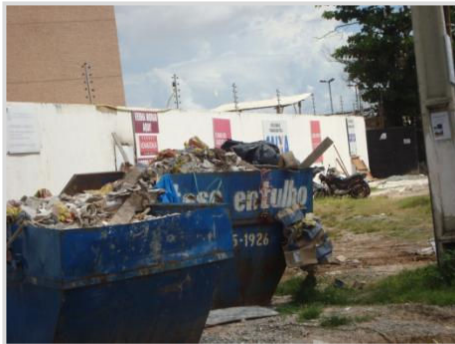
Foto 11 – Material misturado nos contêineres de uma transportadora – no bairro do Renascença: os resíduos estão todos misturados, ou seja não há segregação por classe como estabelecido pela legislação. (18/07/2014)
