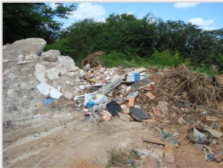
Foto 17 – Local de descarte irregular de resíduos da construção civil – na Avenida dos Franceses- nas proximidades da entrada do bairro Santo Antônio.(27/07/2014)
