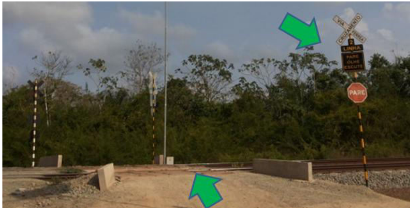
Figura 3.2 – Passagem de Nível sinalizada (Fonte: o Autor, 2013)
