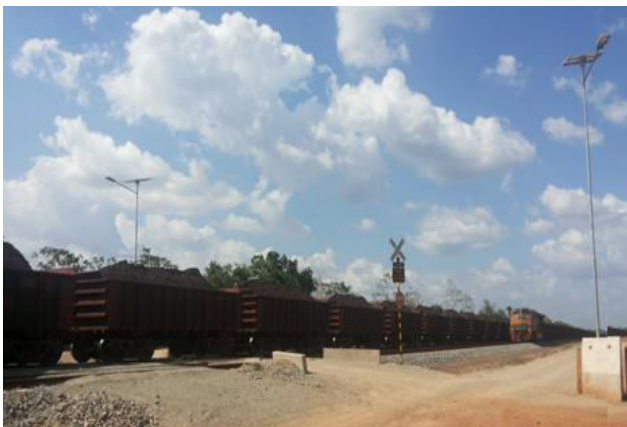
Figura 3.7 – Sistema Duplo de Iluminação Instalado (Fonte: o Autor, 2013)
