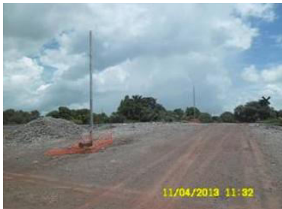
Figura 3.5 – Kit Solar em Instalação – Postes (Fonte: o Autor, 2013)
