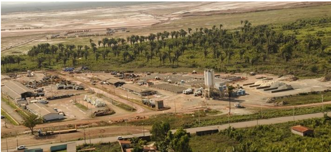
Figura 1: Terraplanagem da Refinaria Premium I em Bacabeira-MA.
