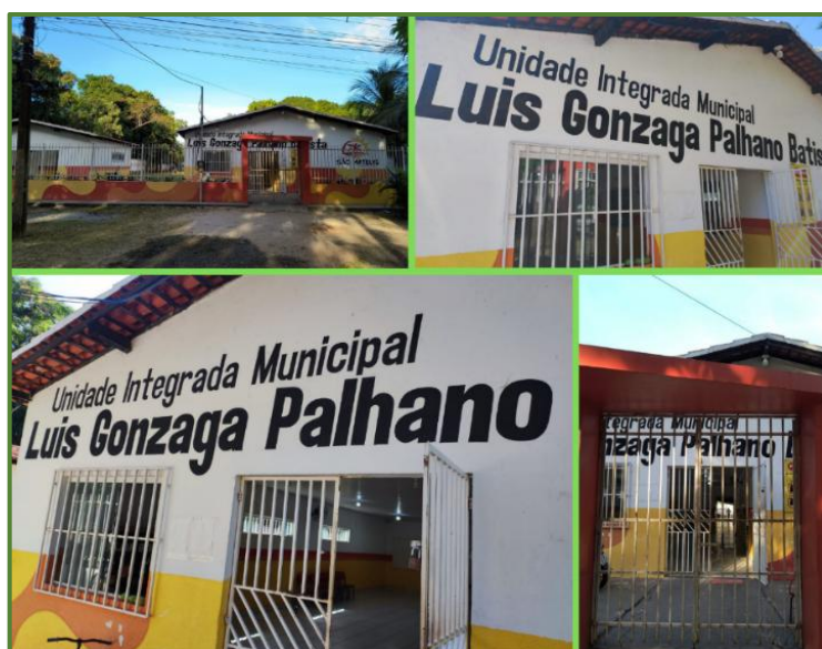
Figura 2: Fachada da Escola
