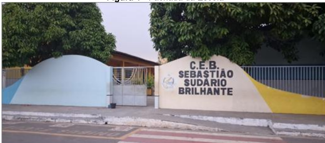
Figura 1 - Fachada da Escola
