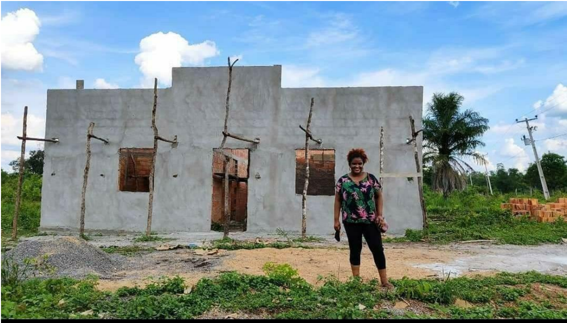
Local onde estão construindo a escola e o posto de saúde. Fonte: ARAÚJO, K D. S. Pesquisa de campo. Pesquisa de campo (2021).
