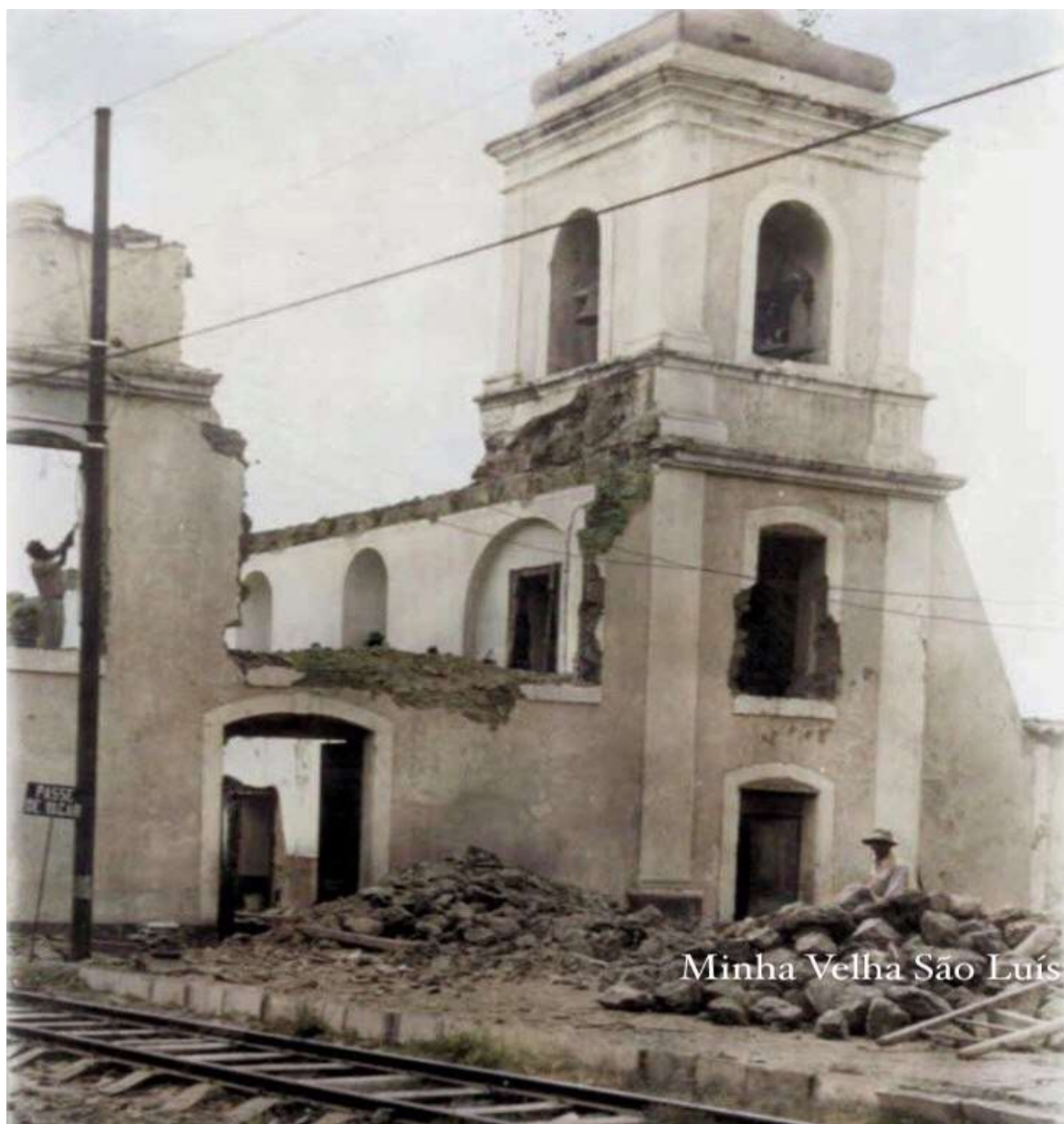
Figura 27- Igreja de Nossa Senhora da Conceição Demolida
