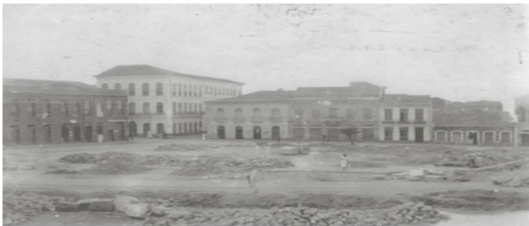
Figura 28 - Demolição da praça João Lisboa
