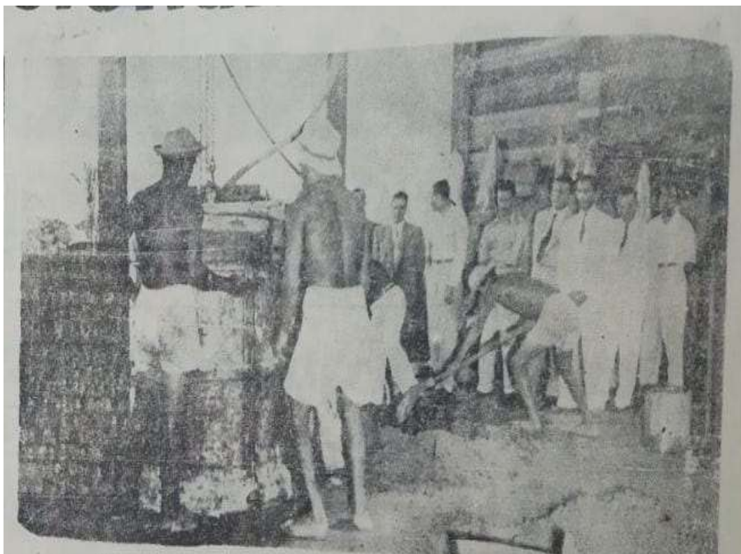
Figura 39 - Operários na construção do conjunto residencial Filipinho
