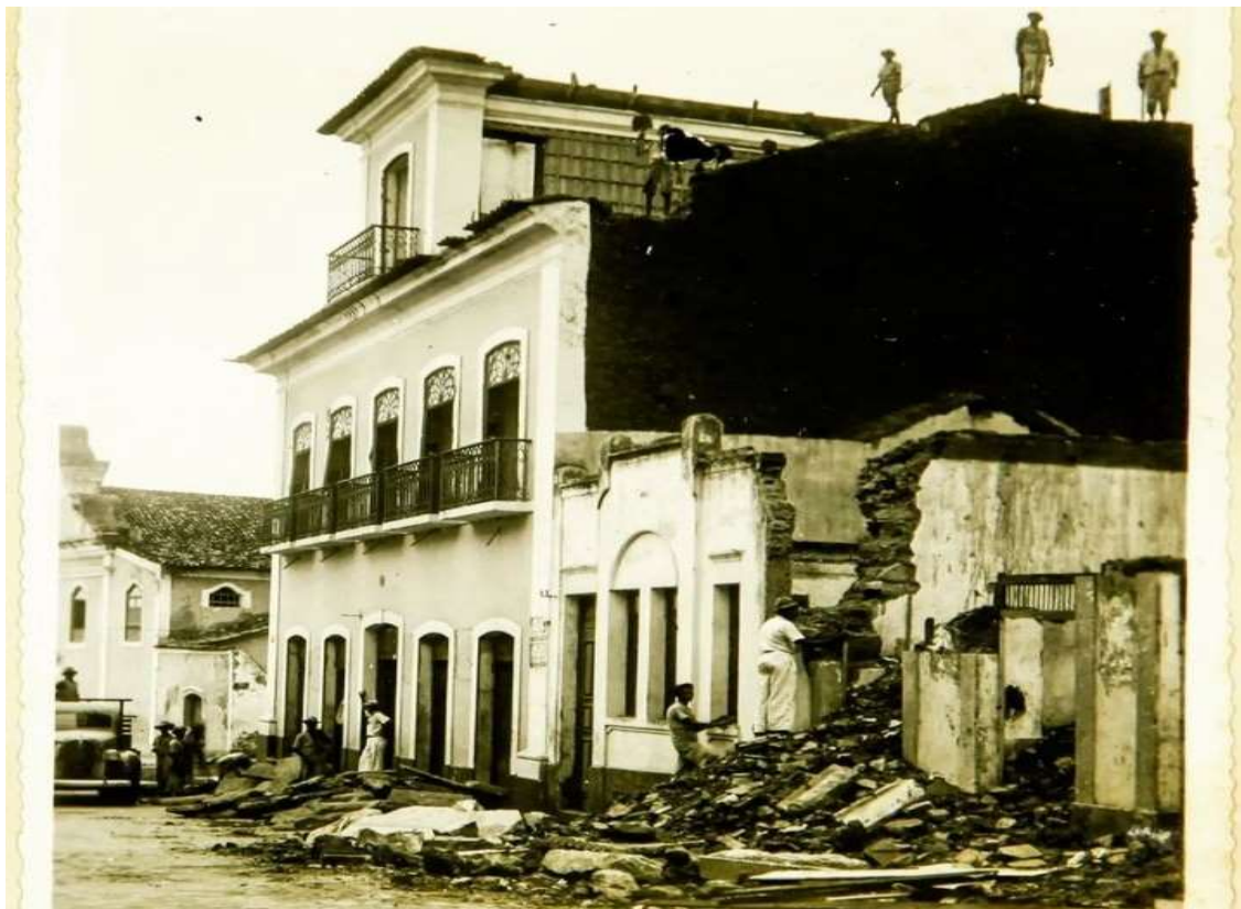
Figura 29- Demolições para alargamento da rua do Egito 1940
