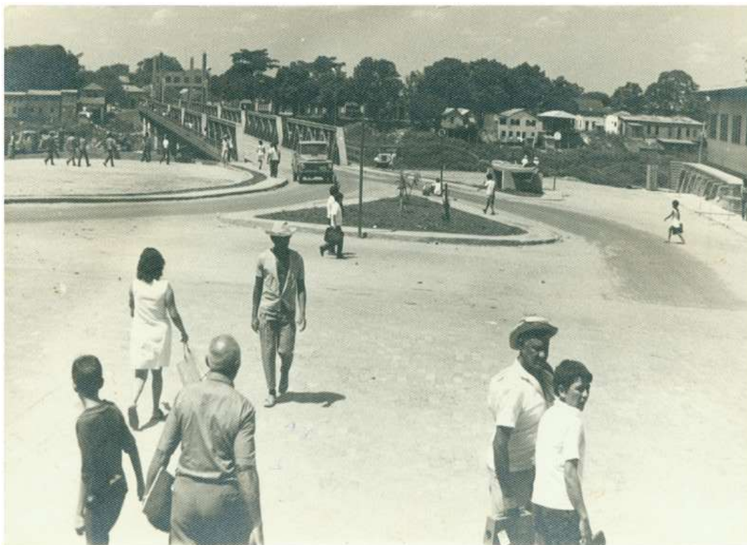
Figura 49 - Ponte Juscelino Kubitschek com Estrutura Metálica
