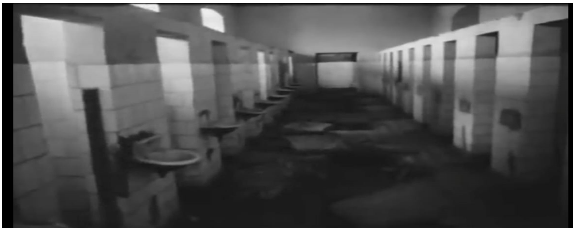
Figura 67- Instituição Pública Inapropriada
