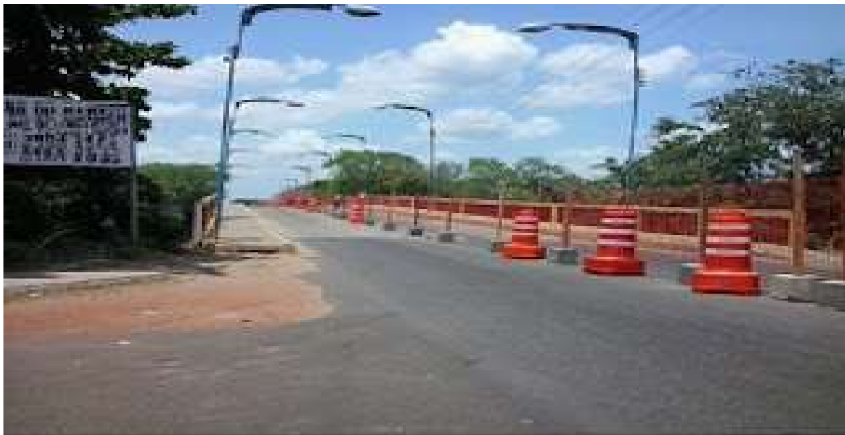
Figura 53- Ponte de Concreto de Itapecuru Mirim
