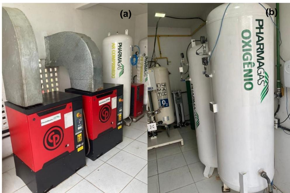
**Figura 10:** Unidades de armazenamento de (a) ar medicinal e (b) oxigênio localizado na Unidade de Pronto Atendimento de Paço do Lumiar
