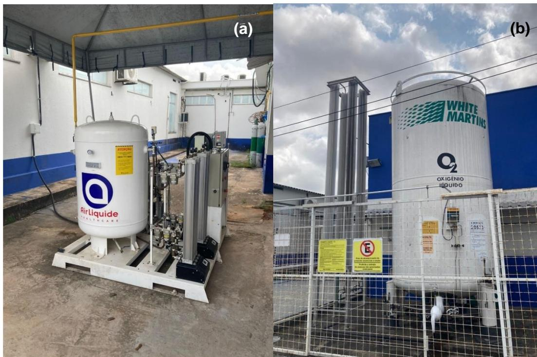
**Figura 11:** Unidades de armazenamento de (a) ar medicinal e (b) tanque criogênico de oxigênio localizado no Hospital Genésio Rego
