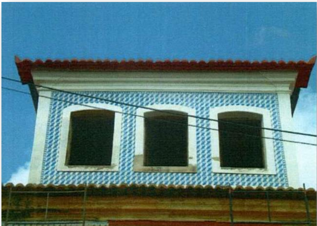
Figura 11- Vista do mirante finalizado após restauração dos azulejos
