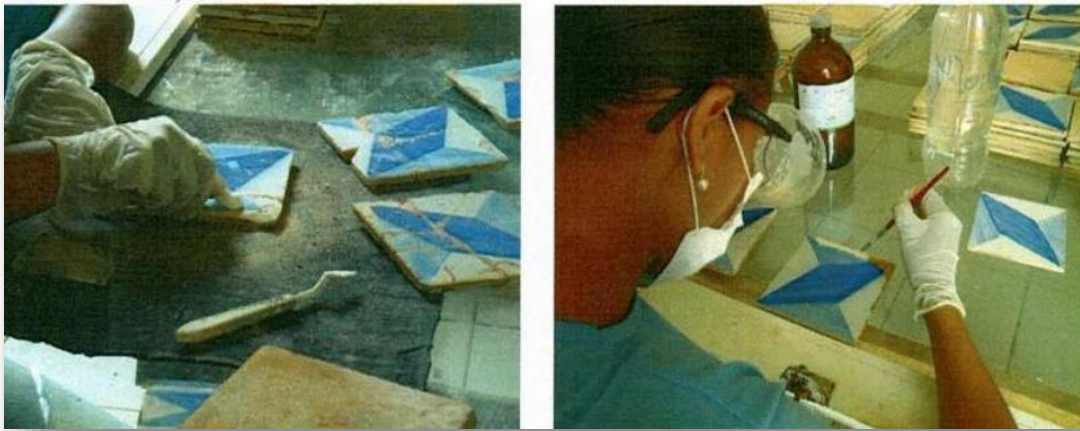
Figura 7- Obturação das lacunas do biscoito e colagem das peças quebradas em bancada
