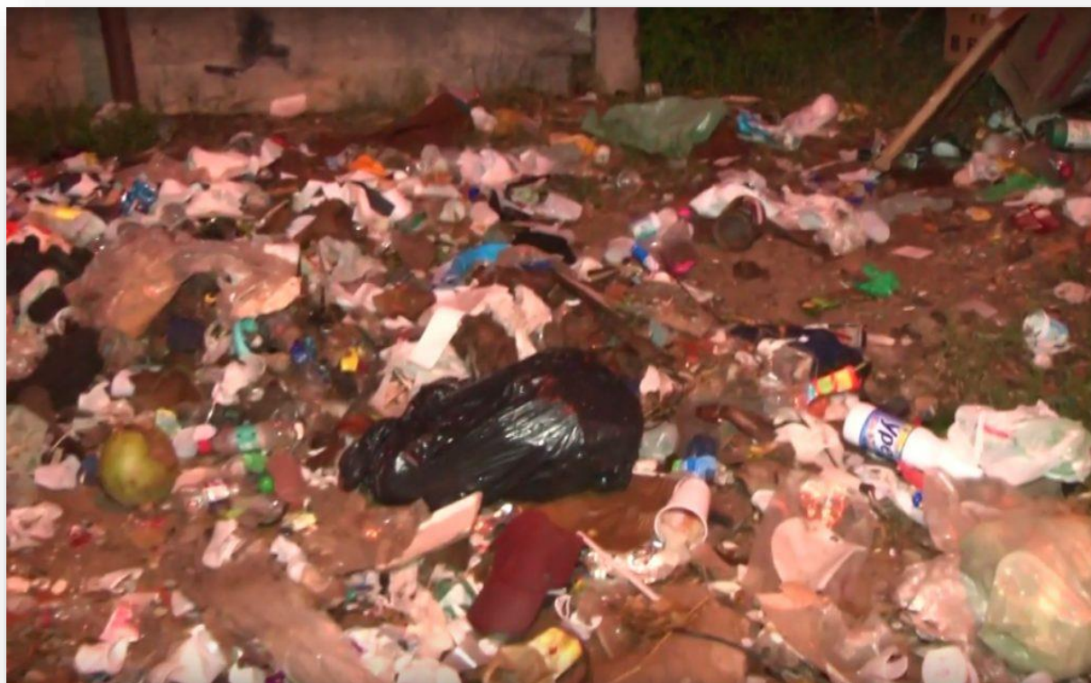
Figura 18 - Antiga Fábrica Progresso – Prédio do Sioge com acúmulo de lixo
