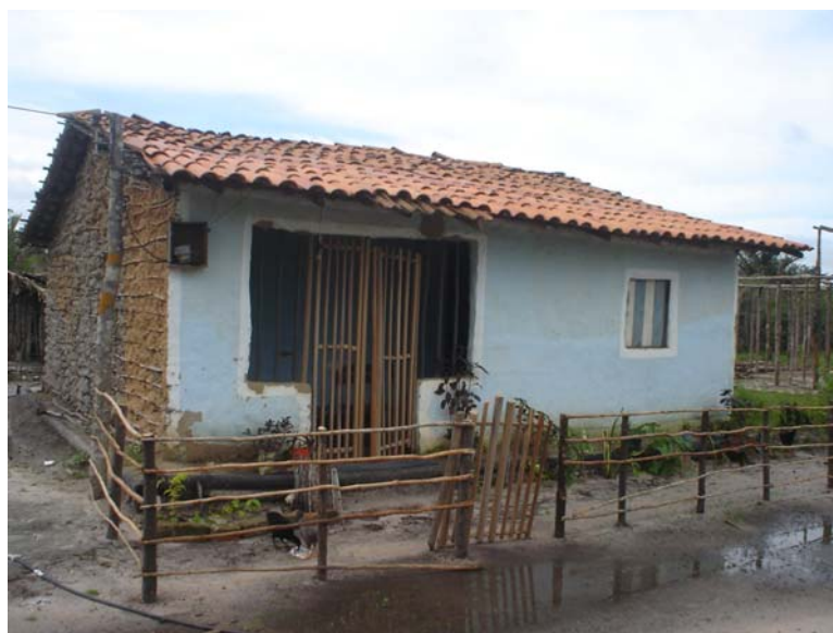
Foto 10: Casa construída de taipa, do lado armação de uma outra casa.
