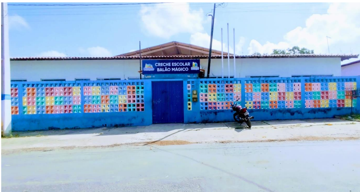
Figura 3 - Creche Escolar Balão Mágico
