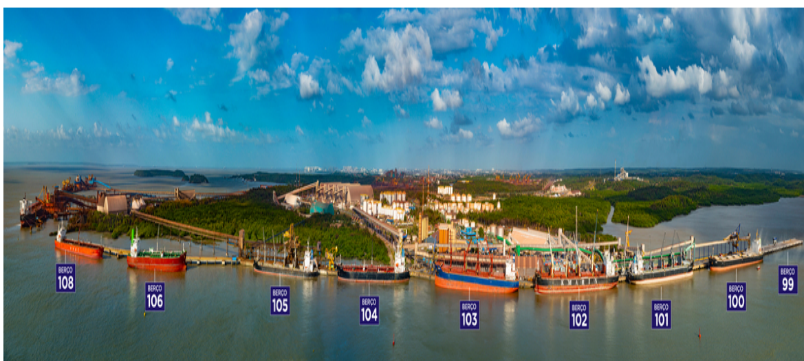
Figura 14: Berços Operacionais do Porto do Itaqui
