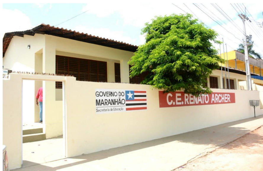
Figura 32 - Fachada do Centro de Ensino Renato Archer/ Maracanã
