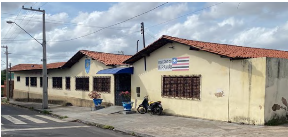
Figura 02 - Fachada atual da Unidade Integrada Governador José Murad
