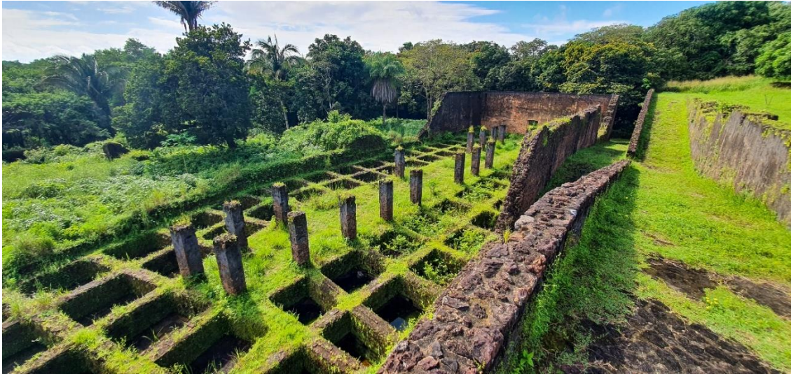
Figura 51: Tanques de curtume
