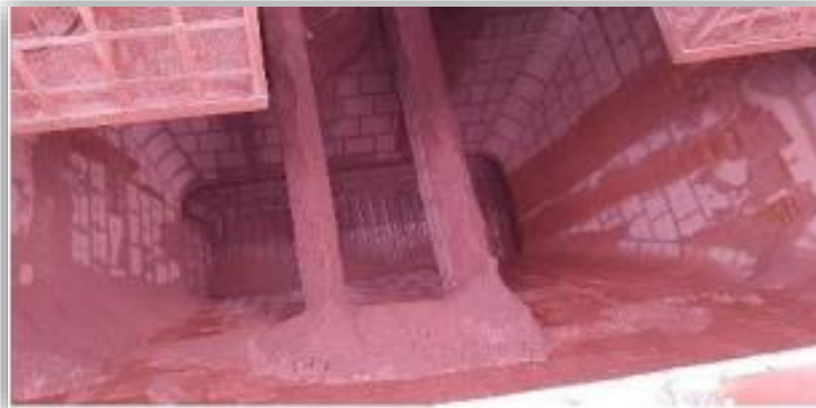
Figura 18 Vista superior de um silo de abastecimento com um AL
