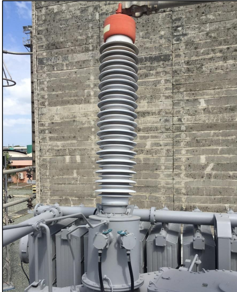
Figura 17: Exemplo de bucha capacitiva do tipo óleo-ar (Acervo do autor).
