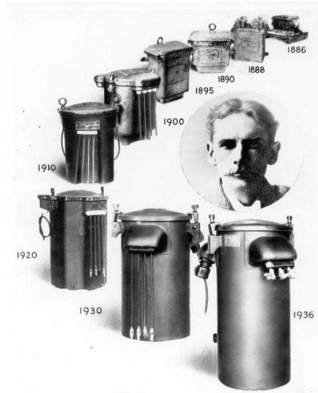
Figura 10: Evolução dos transformadores de distribuição da General Electric, de 1886 a 1936 9 .
