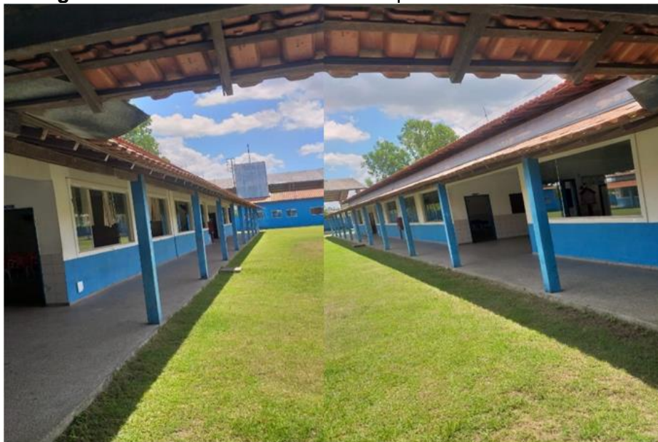
Figura 4 – Pátio externo com suas respectivas salas da UIRAM
