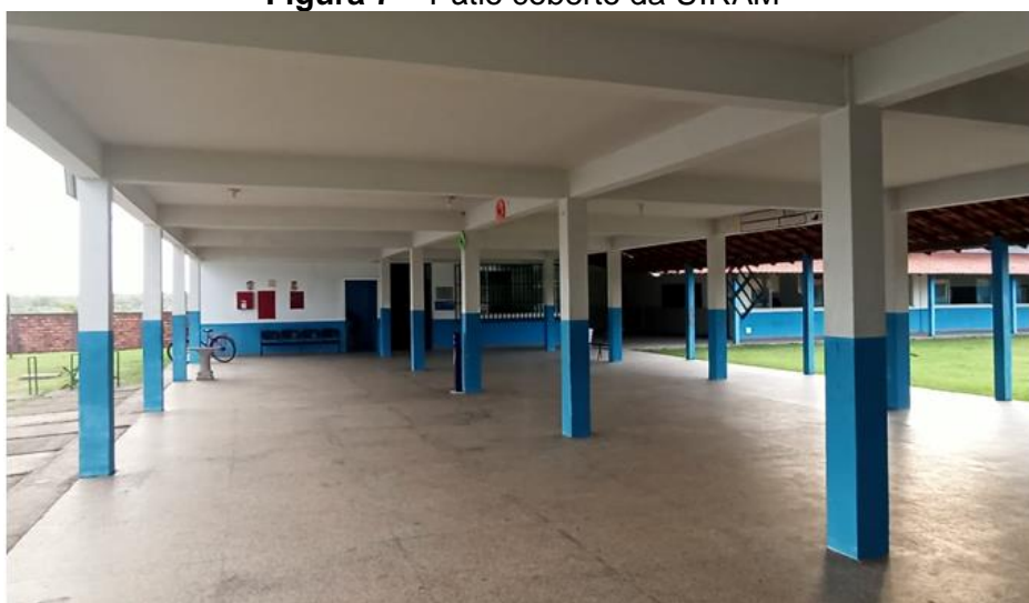
Figura 7 – Pátio coberto da UIRAM
