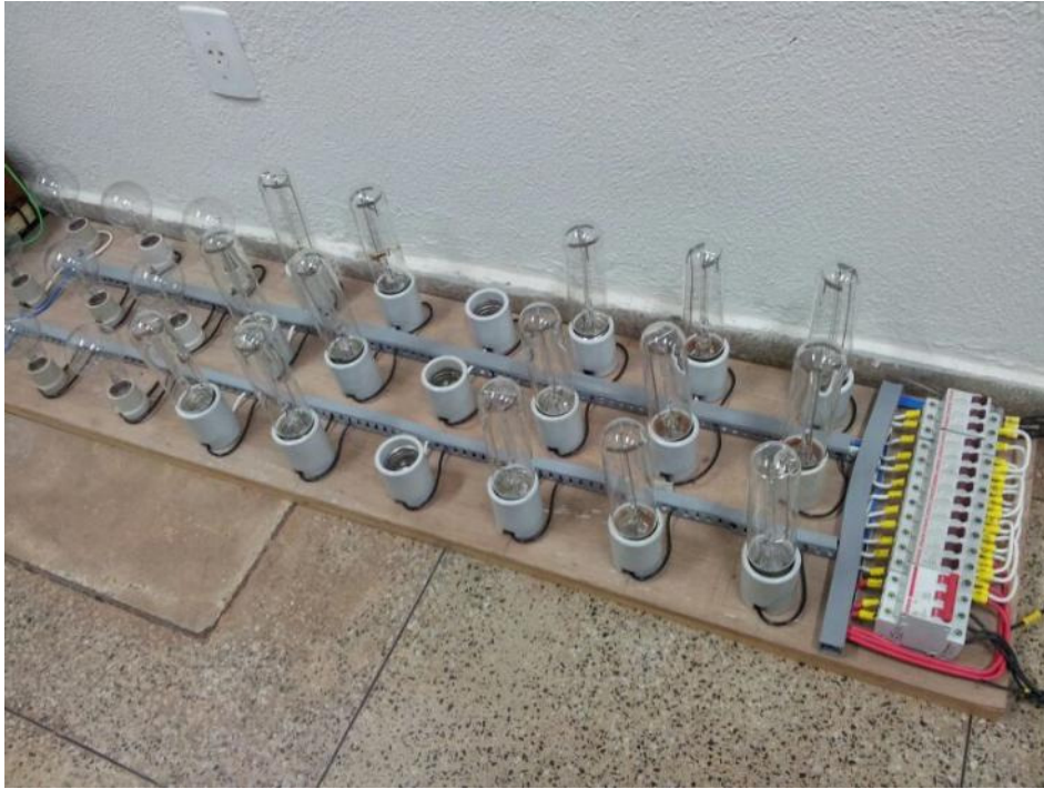
Figura 6-13- Quadro de lâmpadas incandescentes utilizado como carga.
